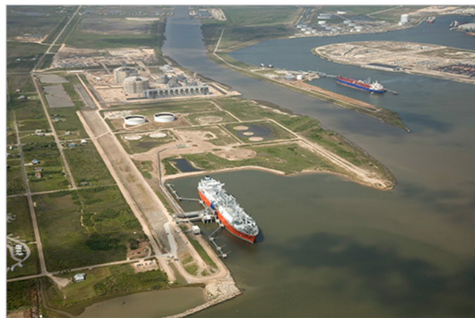
Source: Freeport LNG Development LP
